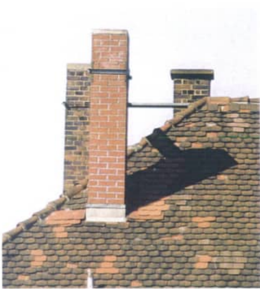
Schornsteine im Ton-Ziegeldach: Klinker
