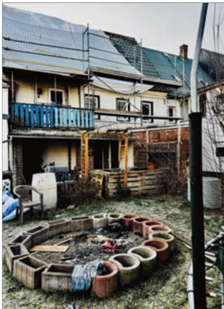
Das Haus Clemens-Pfau-Platz 18 – die Hof-Ansicht.
