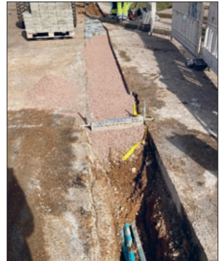
Offener Graben mit Rohrverbund (© GIBY GmbH).
