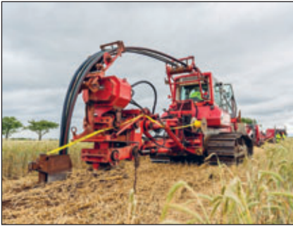
Kabelpflug der GDMcom Bau bei der Herstellung einer Überlandtrasse mit 4 parallel verlegten Schutzrohren (© Nancy Glor).
