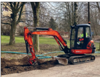
GDMcom Bau Bagger beim Ausheben des Grabens (© GIBY GmbH).
