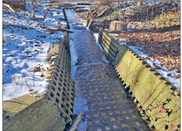
Ein mit Rasengittersteinen verbautes Gewässer. Die Platten sind instabil und im Hintergrund kann man sehen, wie sie bereits ins Gewässer fallen. Zurück bleibt ein ungeschütztes Ufer (Foto: Wetzelt, LFULG).
