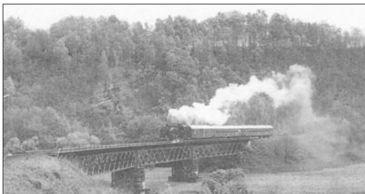
Eisenbahnbrücke von Rochlitz nach Waldheim
