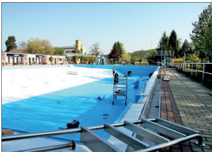
Sanierung Freibad – Im Foto: Mitarbeiter der Fa. Klupsch aus Gerichtshain bei der Auskleidung des Schwimmbeckens mit neuer Kunststoffolie.
