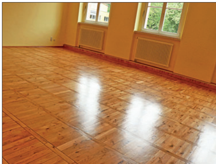
Blick in ein Klassenzimmer der Regenbogen-Grundschule – hier wurde das Parkett geschliffen und anschließend neu versiegelt.
