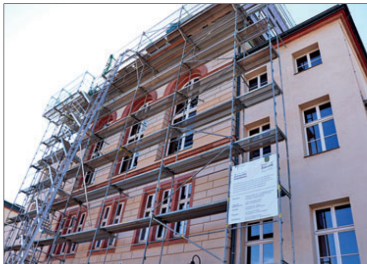
Gerüstbau an der Oberschule „An der Mulde“ zur Dacheindeckung der Aula (im Text nicht erwähnt)
